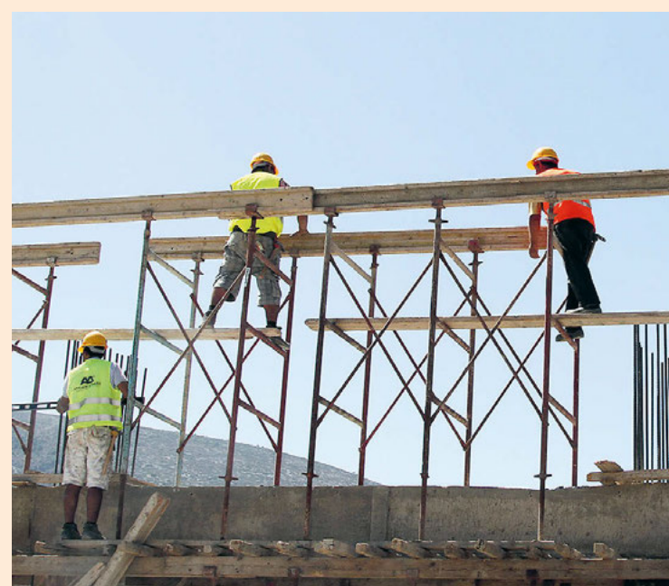
Τον Δεκέμβριο του 2021 ο γενικός δείκτης τιμών υλικών κατασκευής νέων κτιρίων κατοικιών αυξήθηκε κατά 7,1% σε ετήσια βάση.
